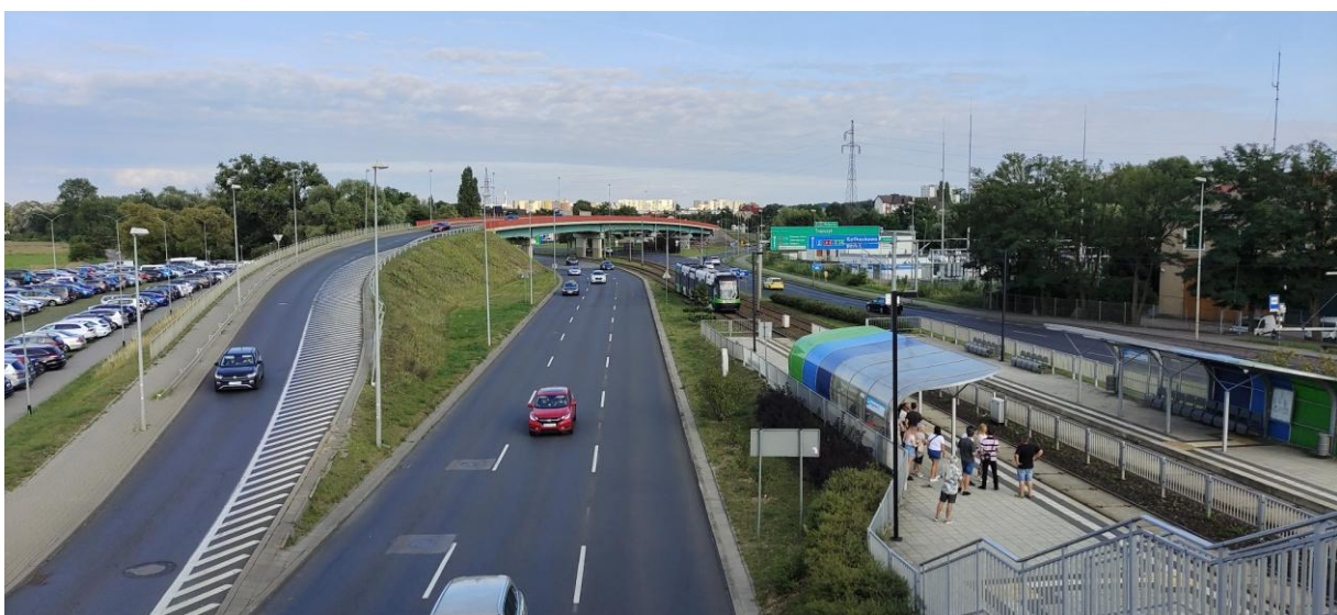
Rysunek 21. Korytarz Szczecińskiego Szybkiego Tramwaju i przystanek Hangarowa N/Ż (z prawej strony) wraz z parkingiem Park & Ride (z lewej strony), dostępnym poprzez pieszą kładkę
